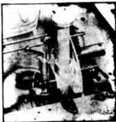
Repos de l'écrou bloquant la bague d'arbre de commande de magnéto
